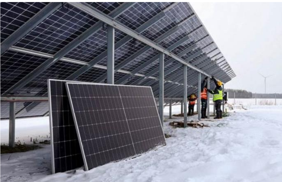
Kuva 6. Paneelit asennetaan 30 asteen kulmaan (kuva Helsingin Sanomat)
